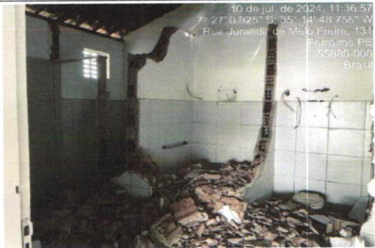
DEMOLIÇÃO DE ALVENARIA
