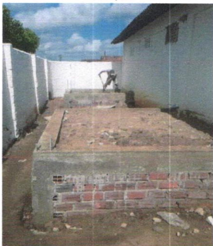
ATERRO + BASE (ALVENARIA DE BLOCOS NA HORIZONTAL)
