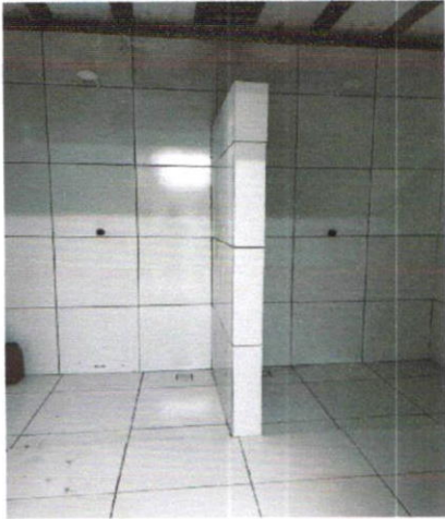
REVESTIMENTO CERÂMICO + CHUVEIRO
