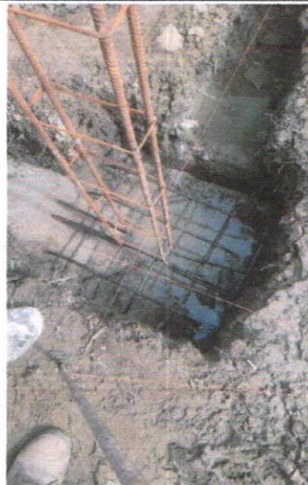
ARMAÇÃO DE PILAR + CONCRETO
